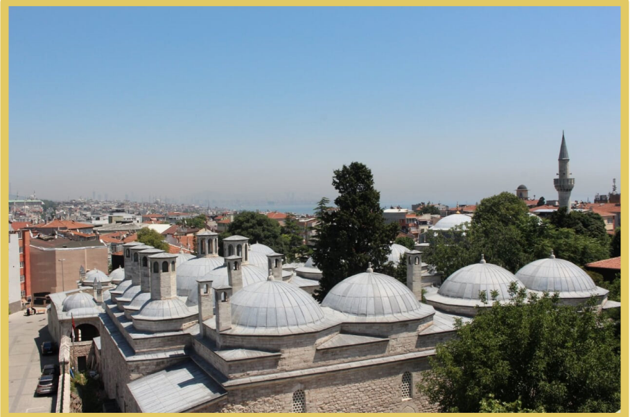
1975-2002 tarihleri arasında Haseki Dini Yüksek İhtisas Merkezi Binası
