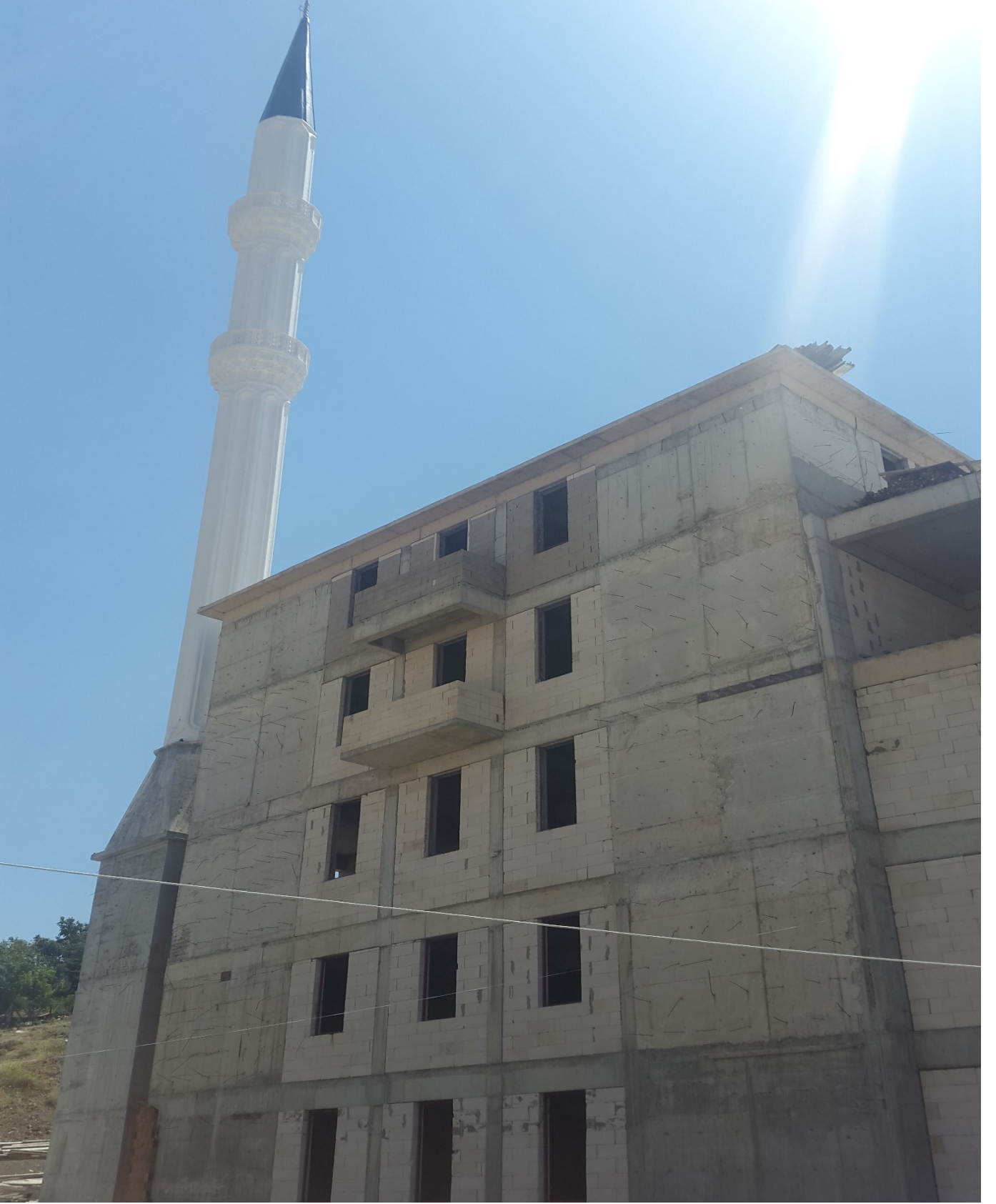
MURADIYE CAMİİ ve KUR'AN KURSU: Kaba inşaatı tamamlanmıştır.
