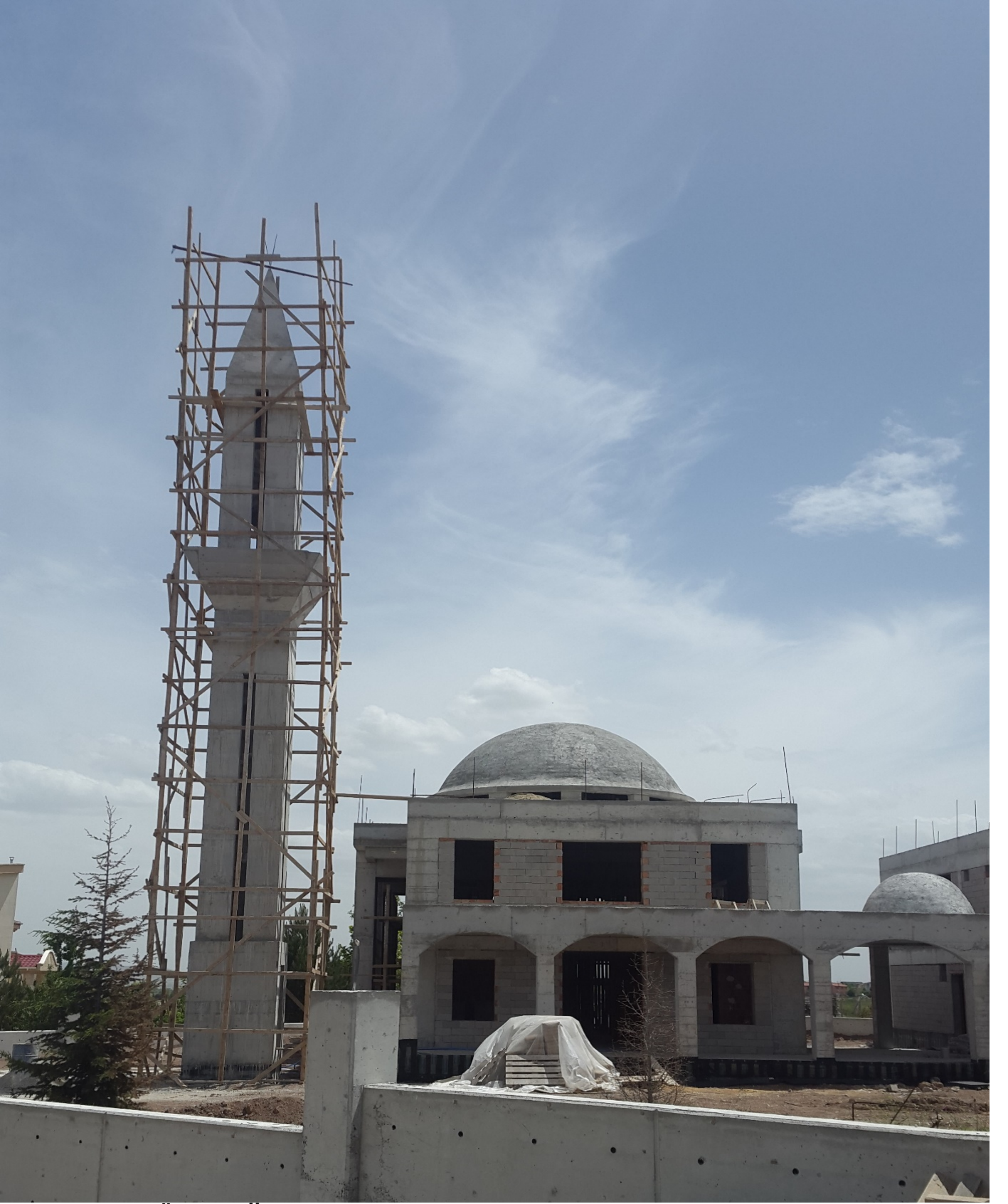
HACILAR KUDÜS CAMİİ: Kaba inşaatı tamamlanmıştır.
