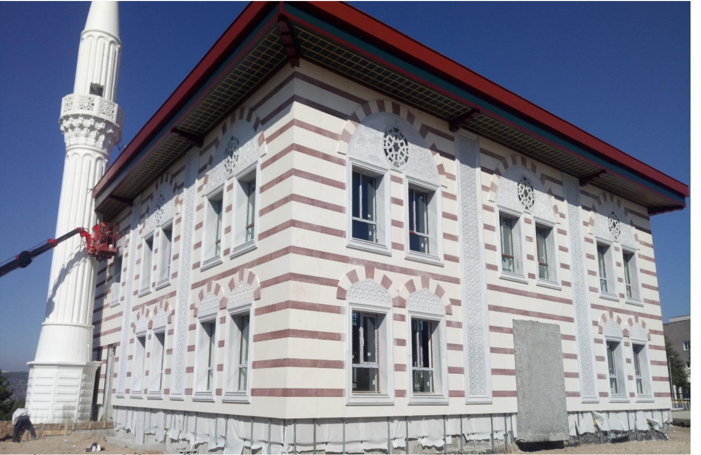
POLİS AKADEMİSİ CAMİİ: İnşaatı tamamlanmış ve ibadete hazırdır.
