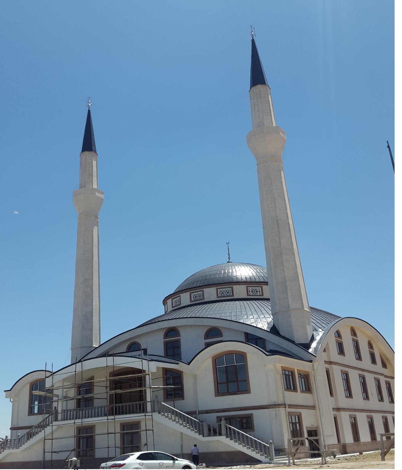
TULUMTAŞ CAMİİ: İnşaatı tamamlanmış ve İbadete hazırdır.
