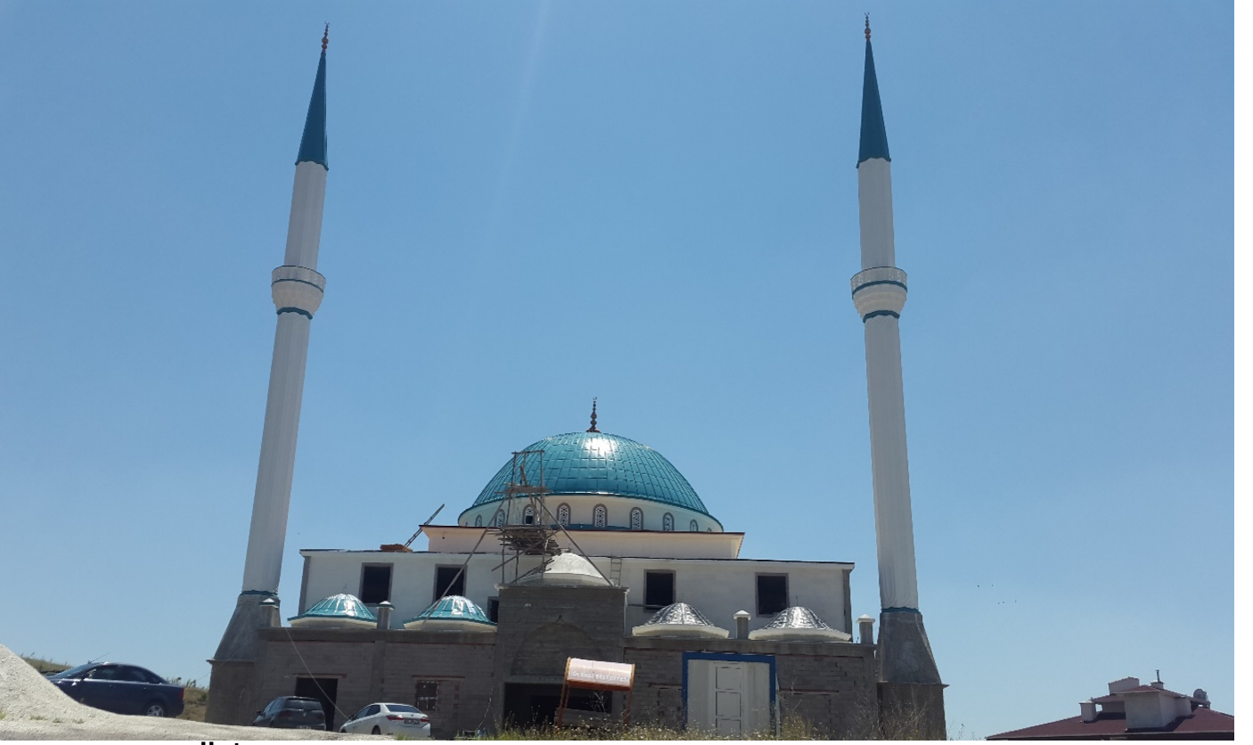
RAHMAN CAMİİ: İnşaatı tamamlanmak üzeredir.
