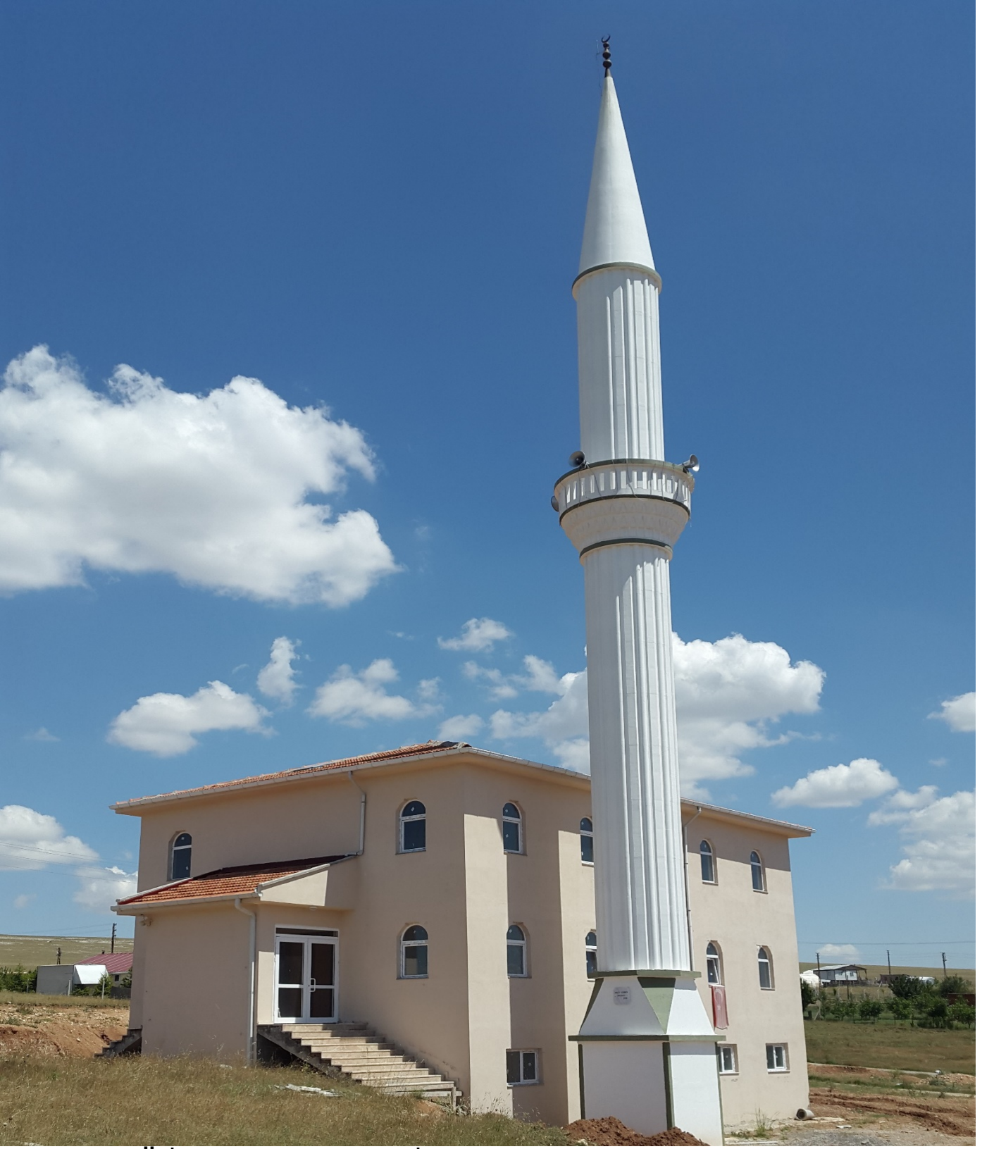
SUBAŐI CAMİİ: İnŐaatı tamamlanmıŐ ve İbadete hazırdır.
