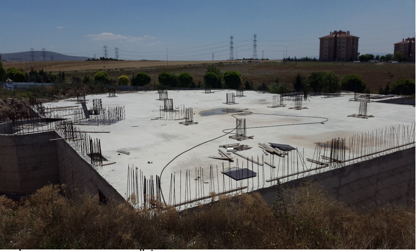
FATİH SULTAN MEHMET CAMİİ: İnşaatı devam etmektedir. Yaklaşık 7.000.000.TL.'ye mal olacaktır.
