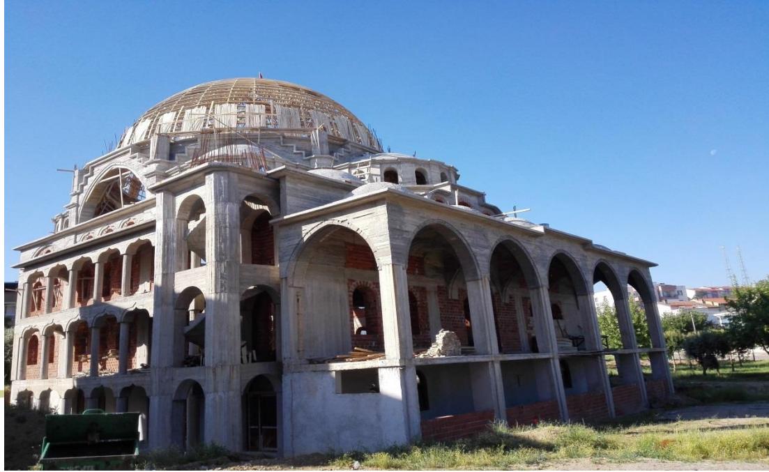
Ergenekon Mahallesi Mevlana Camii
